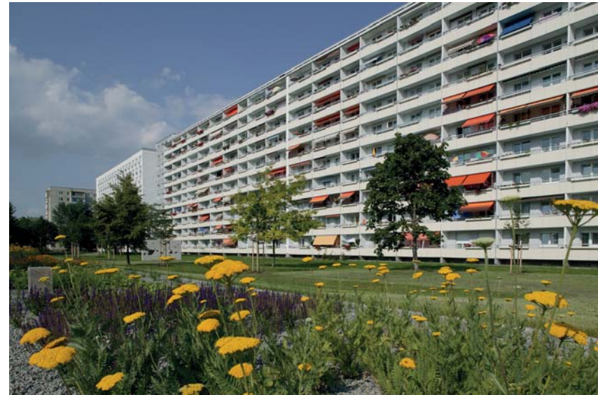
Abb. 7: Halle-Neustadt (Quelle: Stadt Halle)
