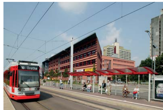
Abb. 8: Halle-Neustadt (Quelle: Stadt Halle)
